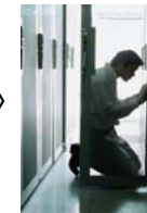
サーバのシャットダウン ラックからの取り外し作業
