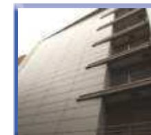
東京日本橋 データセンター
