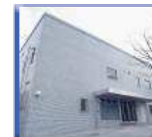
大阪吹田 データセンター
