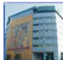
神奈川横浜 データセンター
