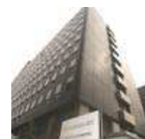
東京新宿 データセンター
