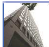
東京新川 データセンター
