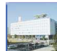
東京有明第2 データセンター
