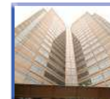
東京虎ノ門 データセンター
