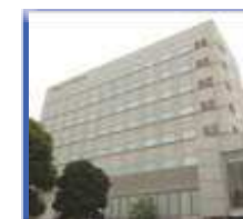
東京有明第1 データセンター
